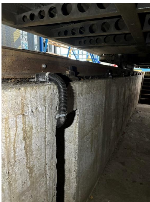
Obr.6 Stávající vyvedení ukolejnění z kanálu
