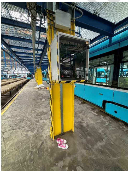
Obr.10 a 11 Rozvaděč DR3 a stávající napájení DR3 s optickým kabelem
