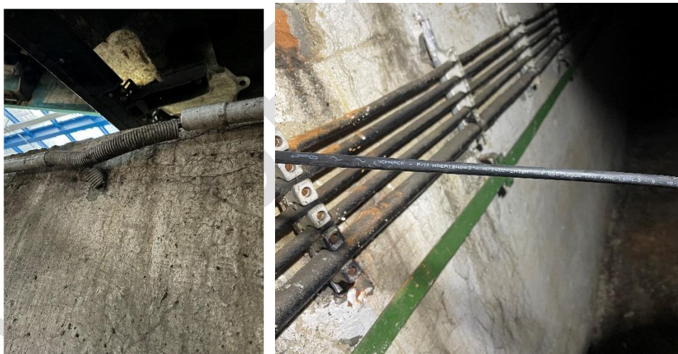
Obr. 13 a 14 Odbočení OPT kábla a typ OPT kábla
