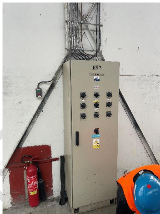
Obr. 18 a 19 Stávající vývody a rozvaděč RS7
