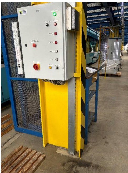
Obr.2 Rozvaděč R01 a místo plánovaného nového kabelového kanálu
