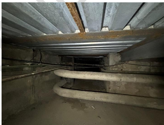
Obr.5 Stávající uložení vodiče H07VK – 1x50
